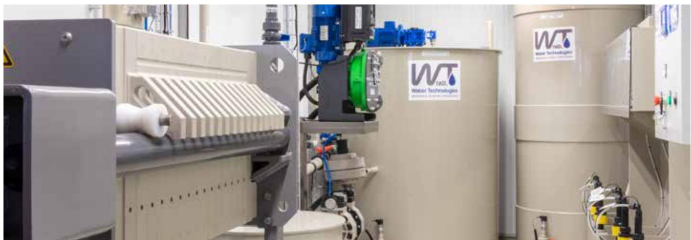
Vue d'ensemble d'une station de traitement d'eaux usées industrielles containérisée. De gauche à droite: filtre presse, réacteur cuve à boues et armoire à réactifs.
